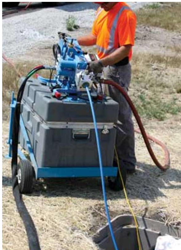
Ilustración 13 máquina de blowing. [12] Fuente www.utilityproducts.com
