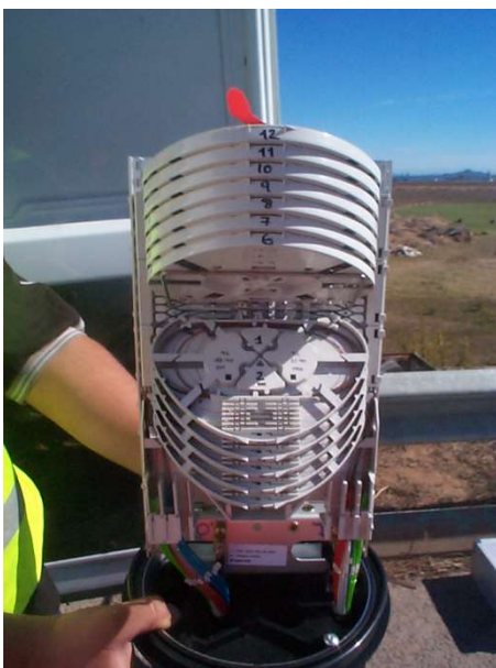
Ilustración 14 Caja de empalme
