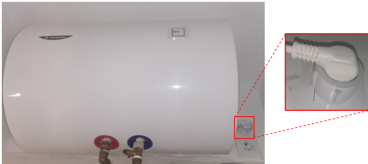
Figura 51. Termo eléctrico monitorizado por un enchufe inteligente de la plataforma Tuya transformado a Tasmota
