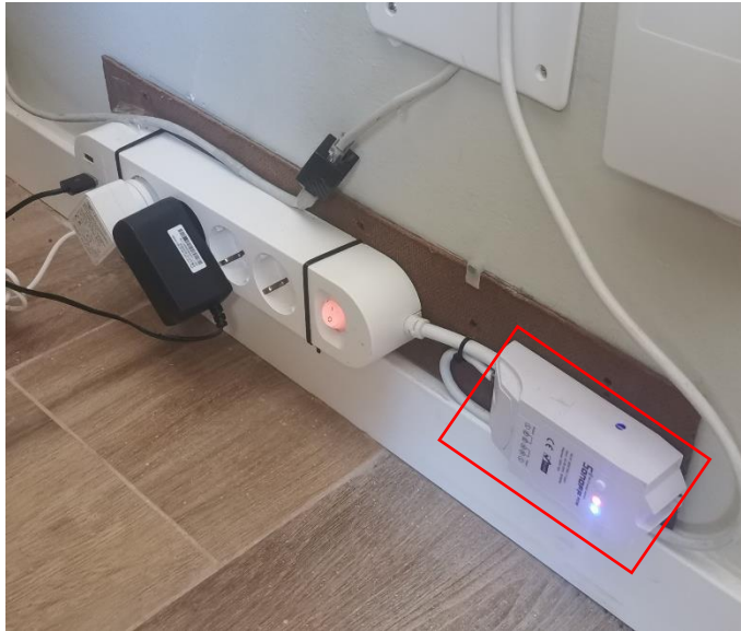
Figura 50. Toda una regleta monitorizada por el sensor Sonoff Pow (en el recuadro)
