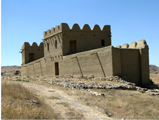
Reconstrucció de la muralla hittita. Foto: R. Orcau.
