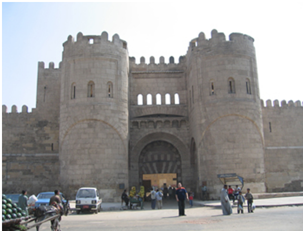
Porta nord de la muralla fatimita de El-Caire. Foto: R. Orcau.
