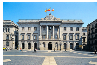
Façana de l'Ajuntament de Barcelona
