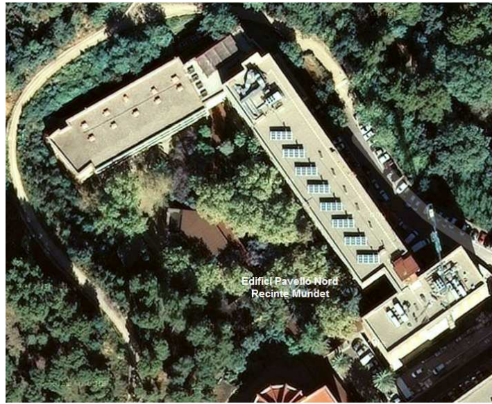
Figura 1. Edifici Pavelló Nord. Recinte Mundet (Google Maps)
