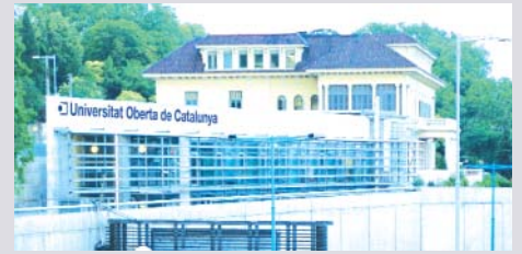
Edificio de la sede central Tibidabo, 39
