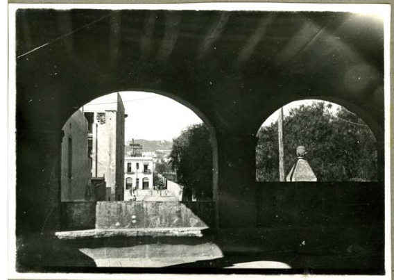
Imatge 48.- Vista de la Travessera cap a ponent des dels arcs de Ca l'Arquer. Fou enderrocada per eixamplar la Travessera i urbanitzar el Passeig de Sant Joan
