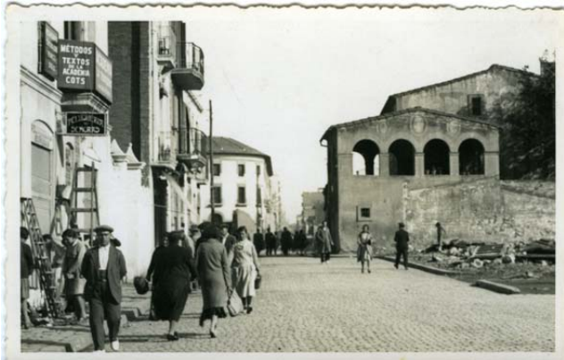
Imatge 47.- Ca l'Arquer, precíós mas situat a la Travessera davant dels terrenys de Cal Comte, ple de frescos a l'interior. Vista des de la Travessera cap a llevant
