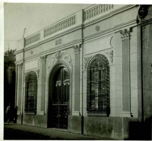
Imatge 27.- Torre Artesania, a Montmany / Encarnació, exemple de tipologia 2 amb el màxim ornament de façana i mides grans. Fotografia dels anys 40
