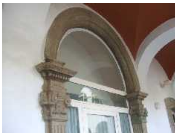
Fig.9: Portal a l'interior del claustre
