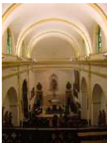
Fig.13: Interior de la capella, coberta amb volta de canó amb llunetes
