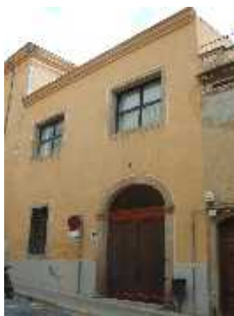
Fig.5: Façana del cos sud, el del quiròfan
