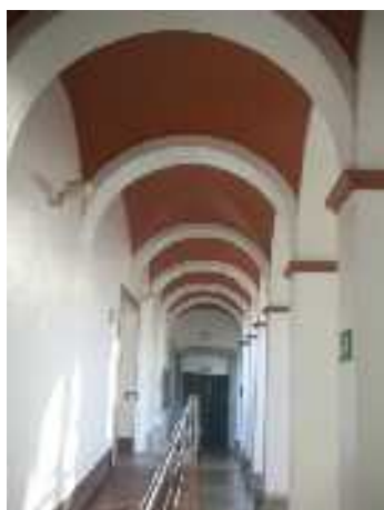
Fig.8: Interior porxo del claustre: trams de volta bufada, exepete tram central volta d'aresta
