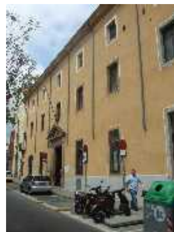
Fig.3: Façana de l'Hospital, amb la capella al fons
