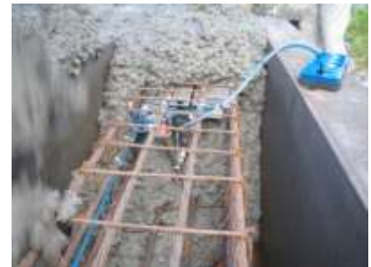
Ilustración 4 Sistema SmartPile antes de fraguar el cemento.
