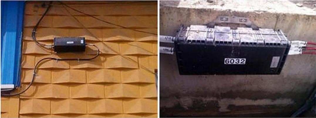
Ilustración [56] Caja de empalme. izq instalación en fachada. Dcha: en arqueta
