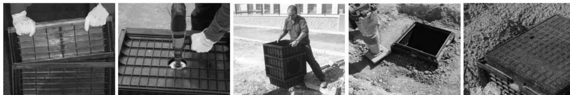
Ilustración [60] Indicaciones sobre la instalación de arquetas
