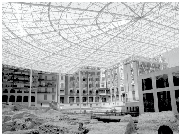
Estructura de protecció de les restes del teatre romà de Saragossa
