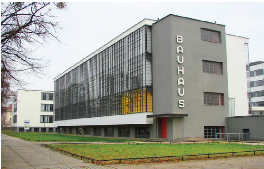
Figura 18.1 – Vista de l'edifici actual d'on es situava la Bauhaus
