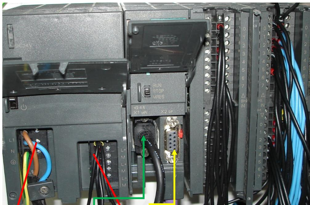
Conexiones de alimentación a tensión de red (230 V AC)      Conexión de alimentación para CPU y conexiones auxiliares de 24 VDC
