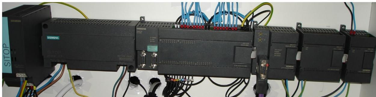
A la izquierda de la imagen se puede ver la fuente de alimentación (conectada a tensión de red de 230V AC), que suministra tensión de 24V DC al autómata y dispositivos que se conecten auxiliarmente compatibles con esta tensión de funcionamiento. En el centro se puede ver el PLC S7-226. En el rack de entradas digitales (parte inferior del autómata), se han conectado los sensores inductivos de una de las estaciones, con el siguiente esquema de conexión (responde a un sensor de tipo pnp):
