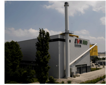
Planta de cogeneració d'electricitat. La crisi energètica va induir a mitjà termini a un ús més eficient de l'energia.
