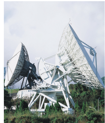
Equips i serveis de comunicacions
