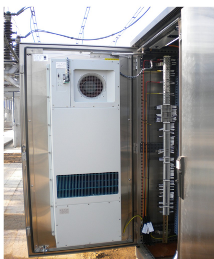
Figura 20. Imatge i característiques del refrigerador HRUC A 020 . Font del catàleg on-line de la empresa Hua Rui Air Cooling Solution , al web itenclosuresystems.com .
