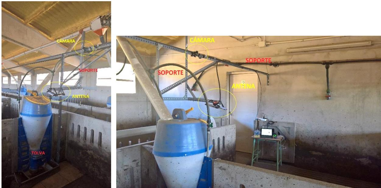
*Ilustración 16. Fotos del soporte para la antena y la cámara.*
