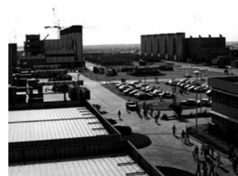
Central tèrmica de gas a l'Àrabia Saudita.
