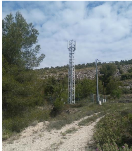
Figura 42. Instal·lació de telecomunicacions no integrada a l'entorn.
