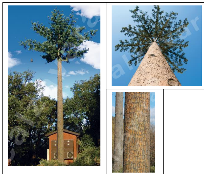
Figura 43. Torre camuflada telecomunicacions. Font: http://www.calzavara.it/
