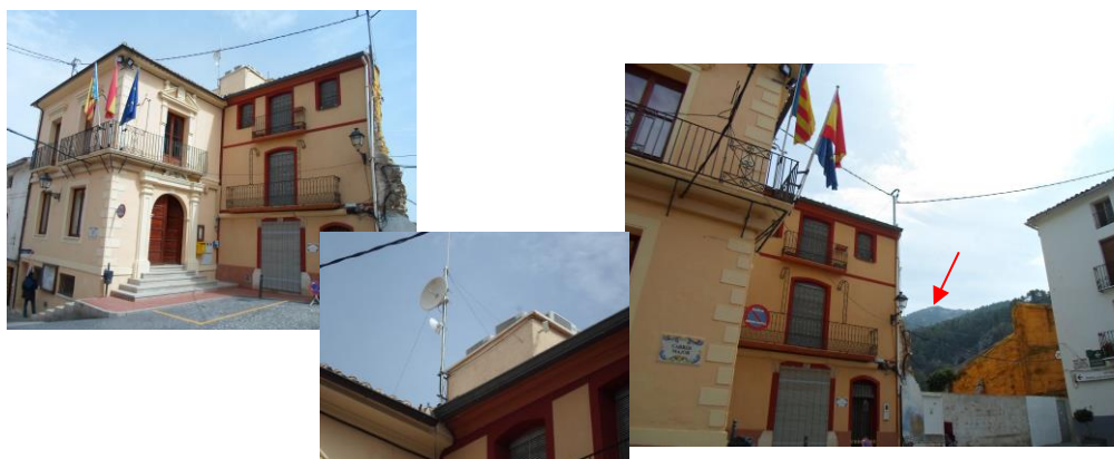
Figura 18. Ajuntament d'Agres i entorn instal·lació estació recepció
