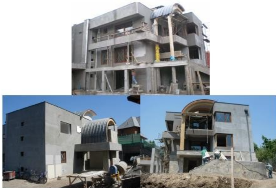
Fotografías del proyecto en obra.
