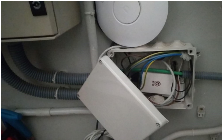
Ilustración 47. En la imagen superior se muestran tres cuadros eléctricos fijos para el control de la cúpula. La raspberri pi se ha instalado en el cuadro inferior y el módulo XBee se sitúa sobre el cuadro izquierdo (no se introduce en ningún cuadro para maximizar el alcance de la señal RF. En la imagen inferior vemos abierta la caja dónde se ha ubicado la raspberri pi
