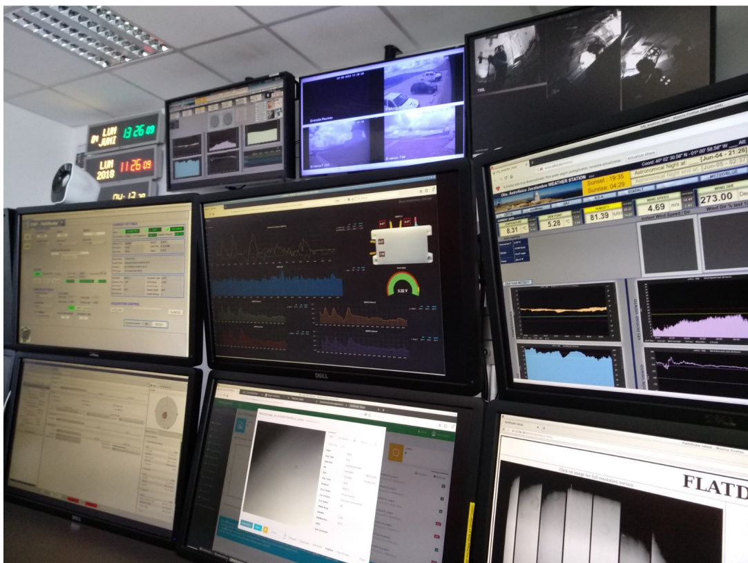
Ilustración 48. Imagen del sistema de monitorización diseñado, desde uno de los puestos de la sala de control principal del observatorio. En la actualidad el observatorio cuenta con tres salas de control, una remota ubicada en la sede de Teruel, otra menor en el propio observatorio, principalmente destinada a el control del telescopio T080 y otra principal, también ubicada en el observatorio, desde la que se suelen controlar todos los telescopios y sistemas y uno de cuyos puestos aparece en estas imágenes
