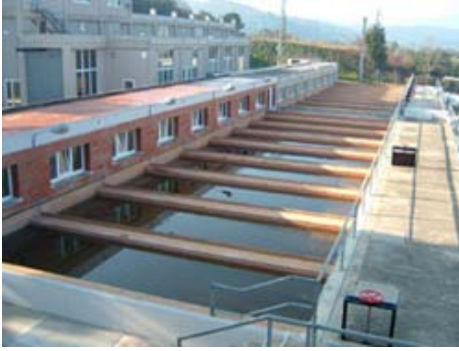
Figura 13 Estació de tractament d'aigua potable (Aigües Girona)
