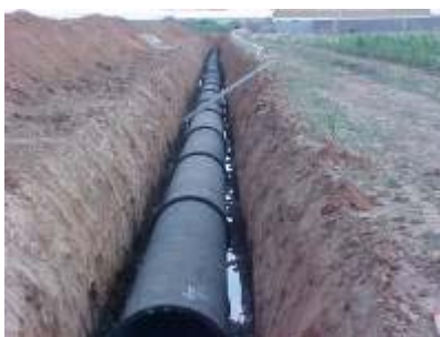
Figura 27 . Instal·lació de canonades d'una xarxa de distribució d'aigua potable
