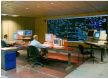
Figura 29 . Centre de control d'una xarxa de distribució d'aigua potable (AGBAR)
