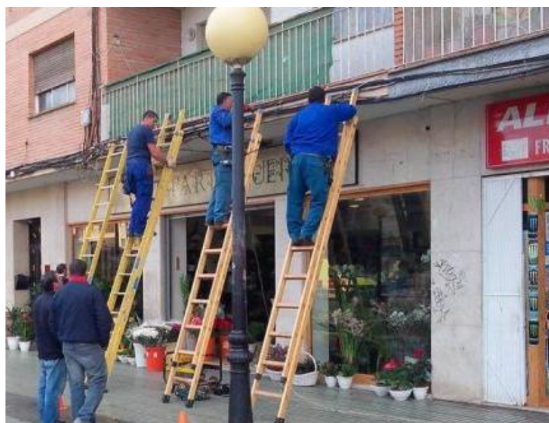
Imagen 30: Ejemplo de tendido por fachada. [30A]
