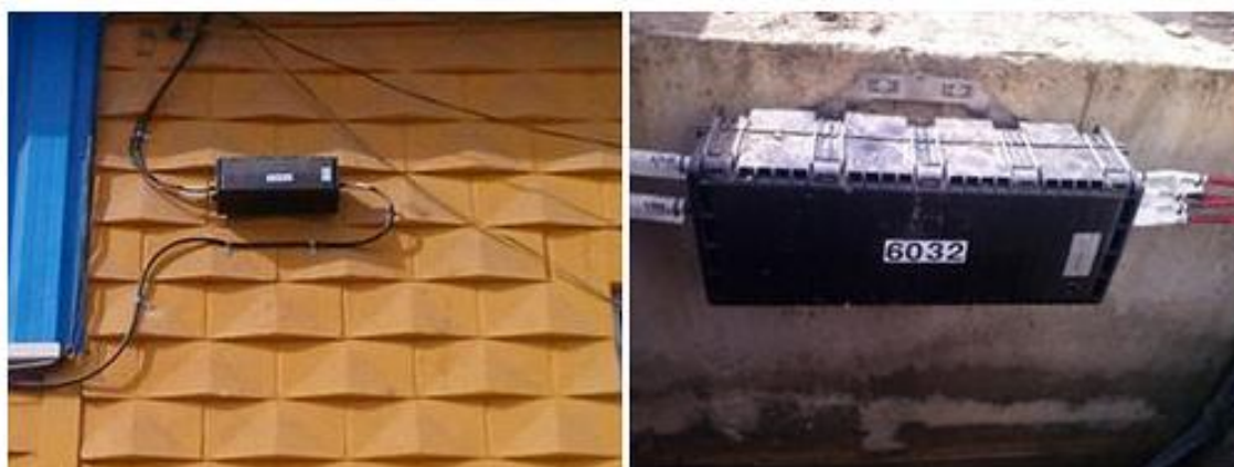
Cajas de empalme en redes FTTH. A la izquierda instalación en fachada y a la derecha en arqueta.
