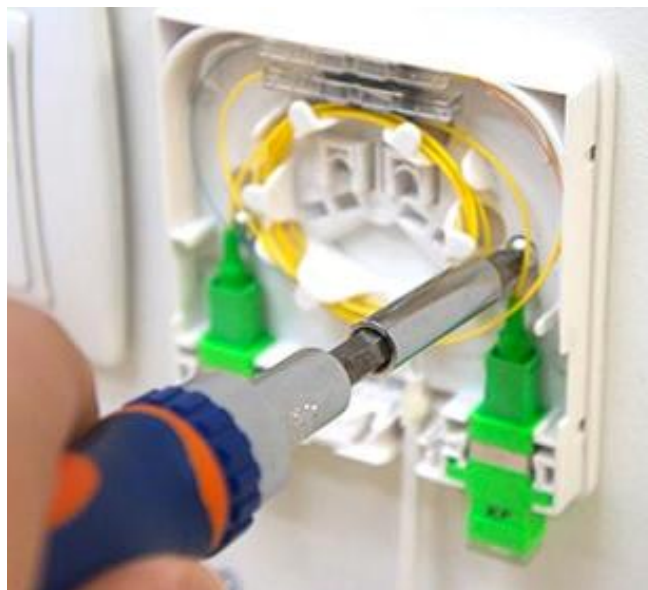
Imagen 56: Roseta óptica marca KeyFibre modelo CTB50 [56A]
