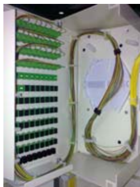
Paneles de distribución y mangueras pre conectorizadas
