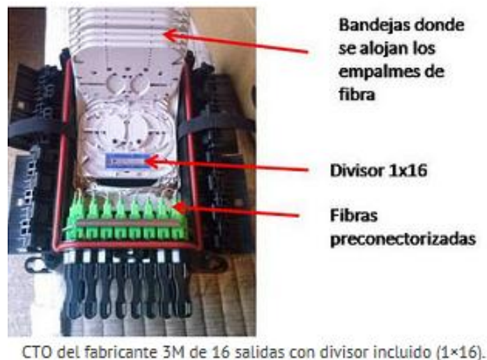
Imagen 55: CTFO de 16 salidas con splitter 1x16 [55A]
