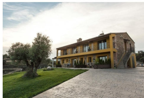
Figura 1: Edifici de Casa Tapioles
