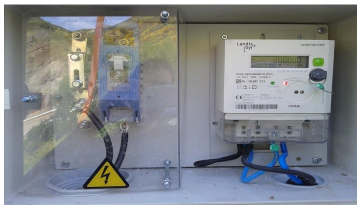
Figura 12. Contador instalado fuera de la casa con fácil acceso.
