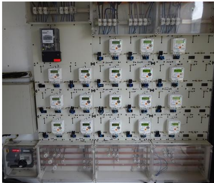
Figura 13. Grupo de contadores eléctricos en una ubicación común.
