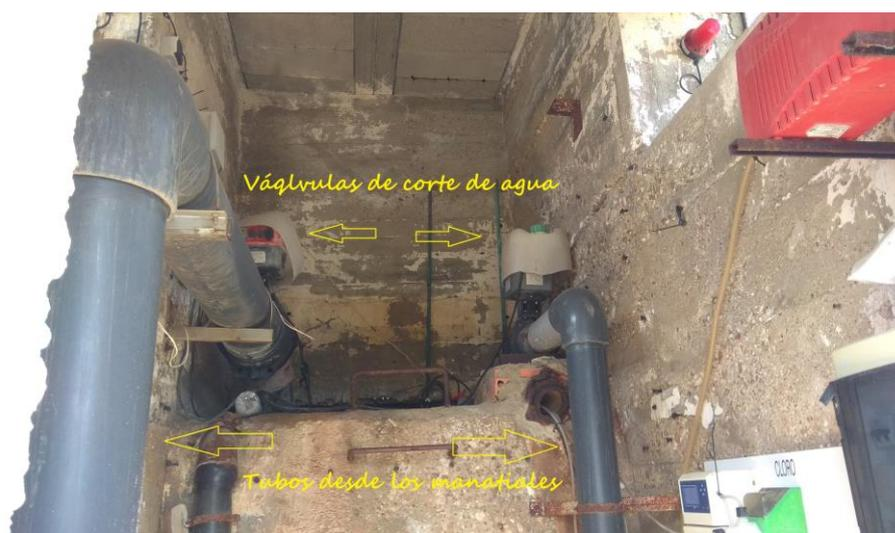
FIGURA 43. VISTA INTERIOR DEL DEPÓSITO.
