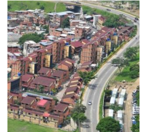
Villas del Sol
