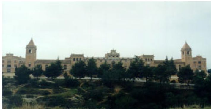
Vista panoràmica de la cara nord de l'edifici del Seminari
