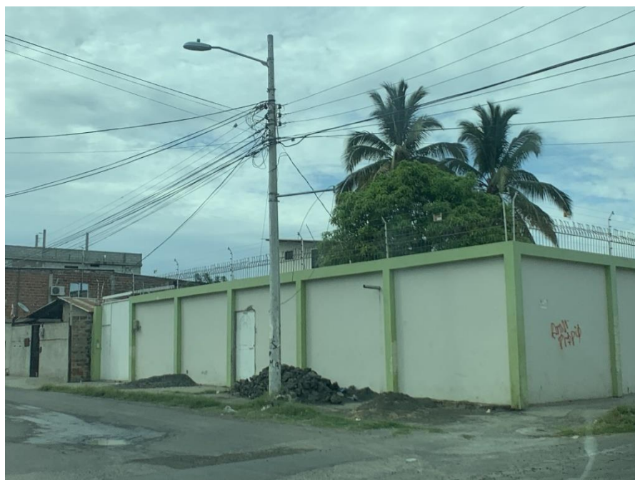
Ilustración 19: Predio identificado con falta de mantenimiento puntual. Fotografía: Angel Vera
