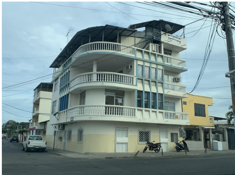
Ilustración 15: Predio catalogado como de visibilidad diurna suficiente. Fotografía: Angel Vera
