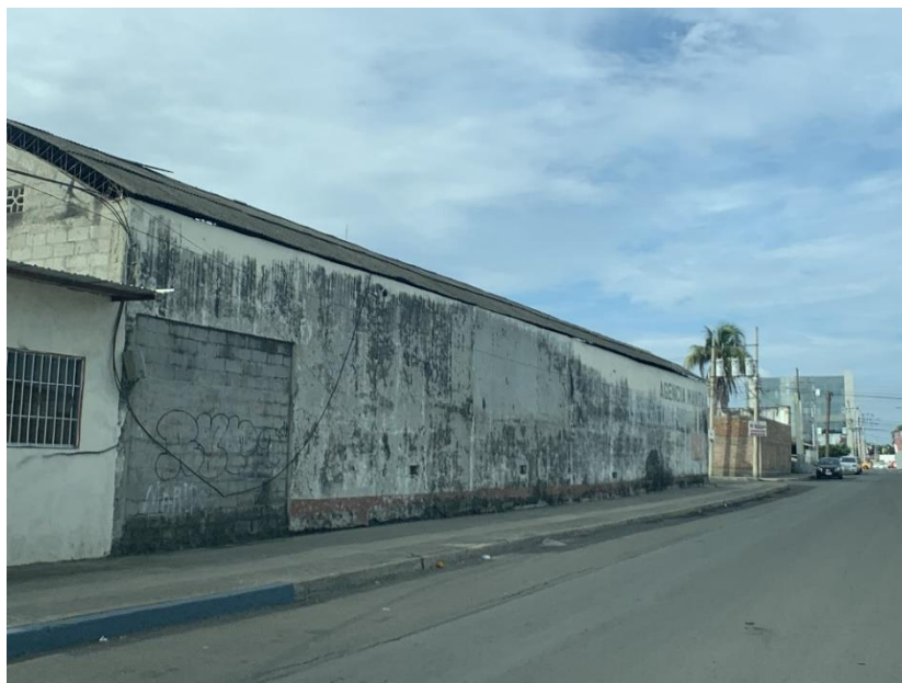
Ilustración 22: Tramo de terreno identificado sin acceso alguno. Fotografía: Angel Vera
