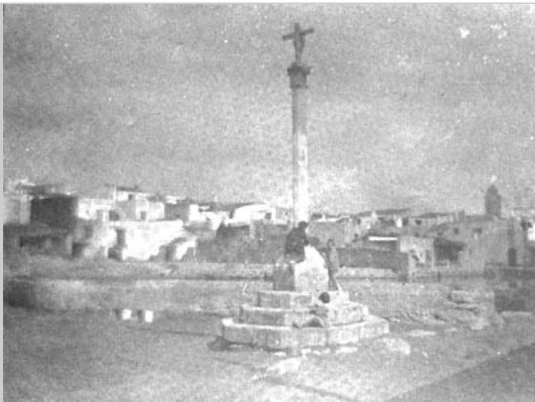
La bassa, amb el prigó, a començaments del segle XX
