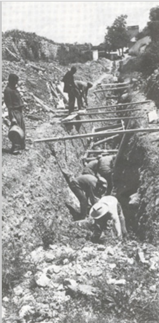
Primeres obres de la xarxa d'aigua corrent. 1962
