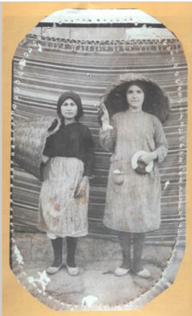
Carrejadores d'obra, als anys 20
