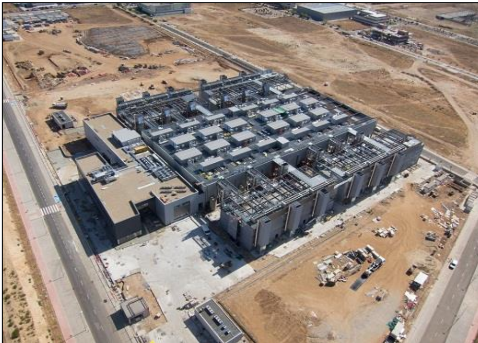
Ilustración 19 - Imagen del Datacenter de Telefónica en Alcalá de Henares.
