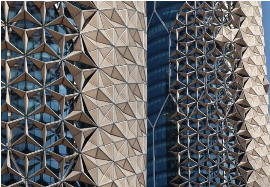
Figura 7. Mecanismo de las torres Al Bahar [23]
