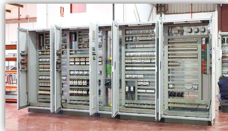
Ilustración 16 - Cuadro eléctrico en proceso de montaje
