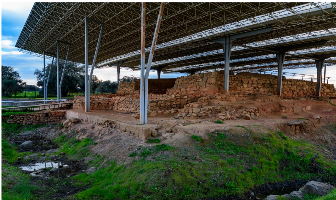
Figura 1.- Cubierta metálica de Cancho Roano. Se puede visualizar, además de la cubierta, otros elementos de musealización como la pasarela de madera y las estructuras negativas y positivas arqueológicas que conforman el santuario (fachada oriental, foso...)
