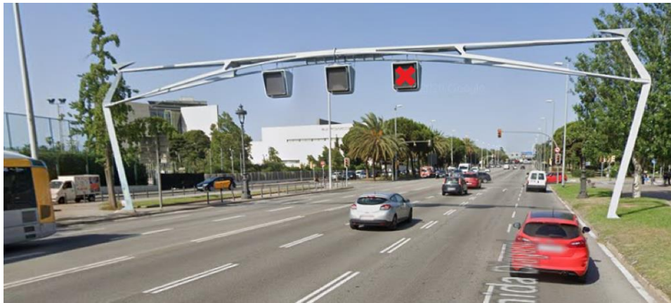
Ilustración 32 - Ejemplo de un panel de la Diagonal indicando un carril bloqueado. Imagen de Google Maps.
