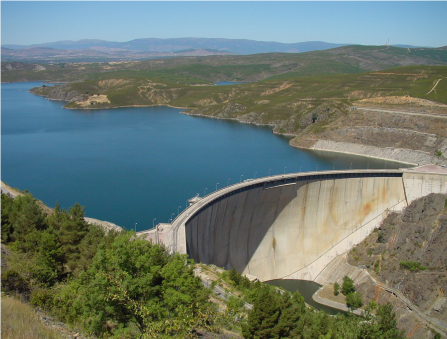
Figura 9. Presa de l'embassament de El Atazar, riu Lozoya
