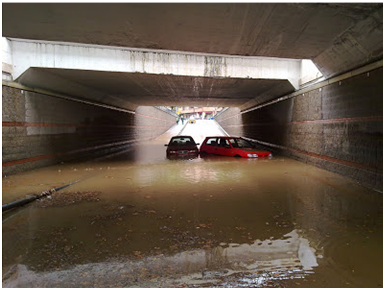
Figura 15. Pas soterrani inundat per l'acumulació d'aigua posterior a un episodi de precipitació torrencial a la població de Castelldefels
