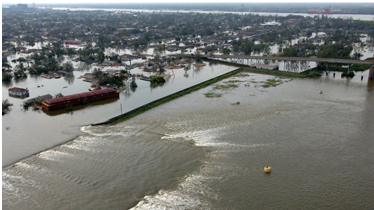
Figura 18. Ruptura d'un dic provocada per l'huracà Katrina a Nova Orleans, Louisiana, EE. UU., el 2005
