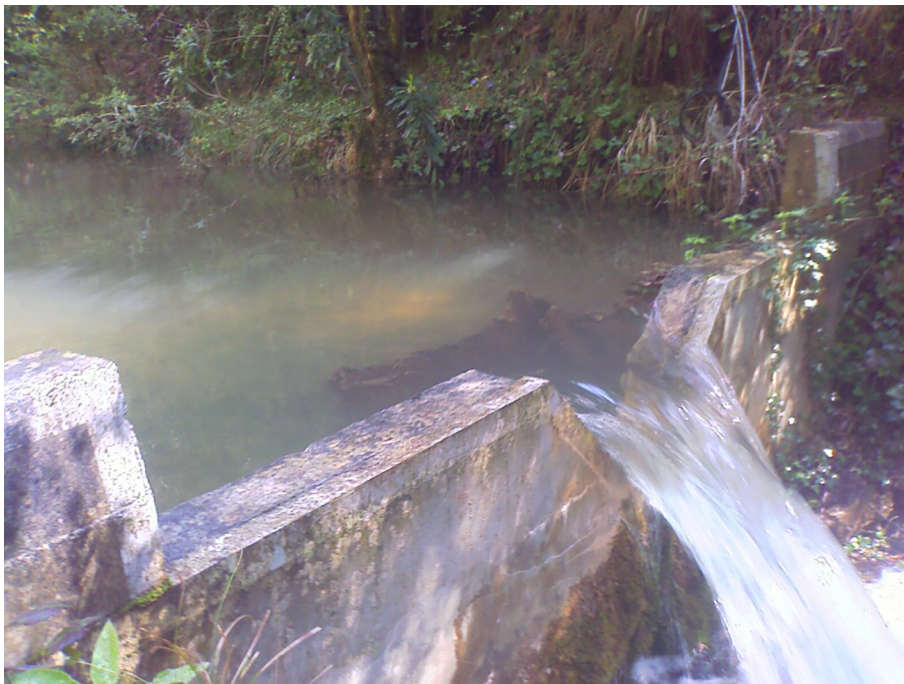
Figura 52. Estació d'aforament de Cogulers (Ribera Salada) formada per un sobreixidor de llavi fi amb una secció composta, triangular per aigües baixes i rectangular per aigües altes
