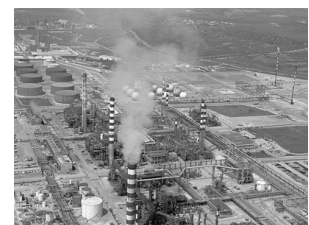
En la imatge, vista general de les instal·lacions d'una refinaria a Tarragona
