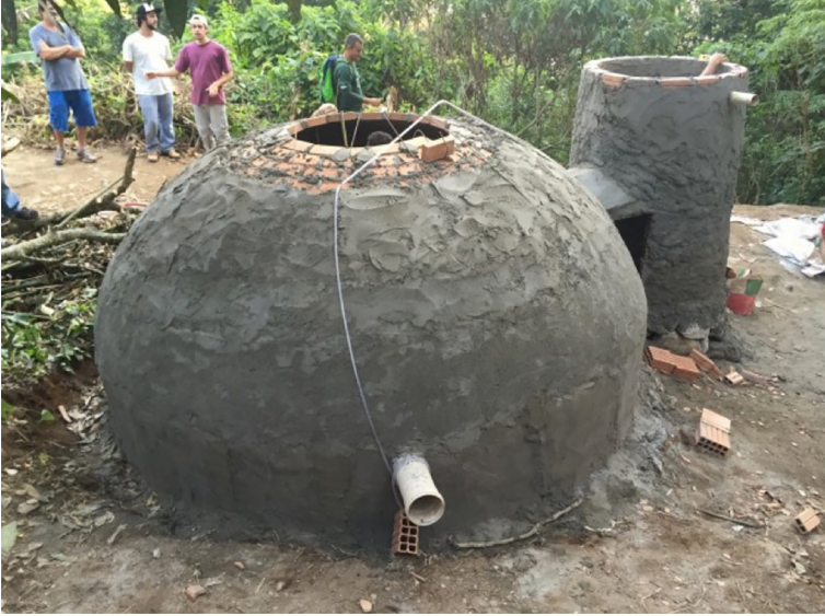
Figura 5. Biodigestor construido en la comunidad.
