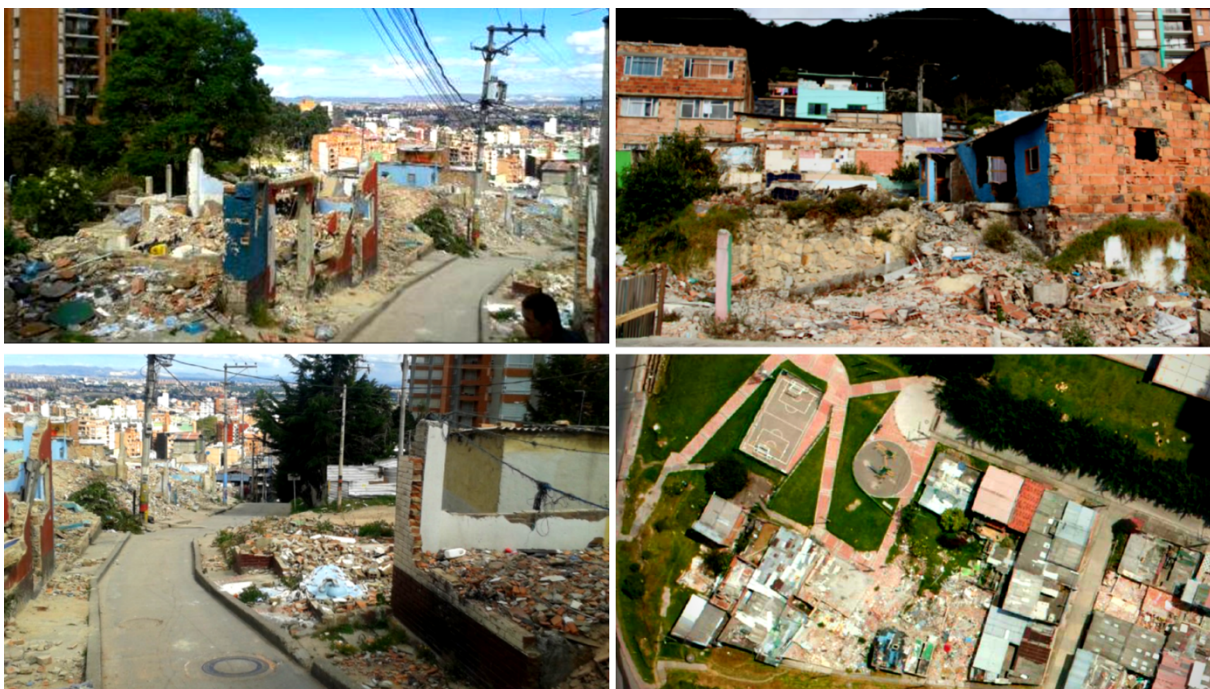
Figura 15. Fotos de la situación de los inmuebles demolidos dentro del Barrio Fuente: Documento Técnico de Soporte, Metrovivienda, 2015
