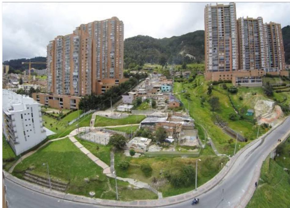
Figura 14. Barrio Los Olivos: Estado inicial antes de la ejecución del proyecto Fuente: Documento Técnico de Soporte, Metrovivienda, 2015
