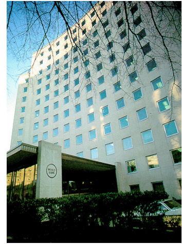
Edificio del Banco Mundial
