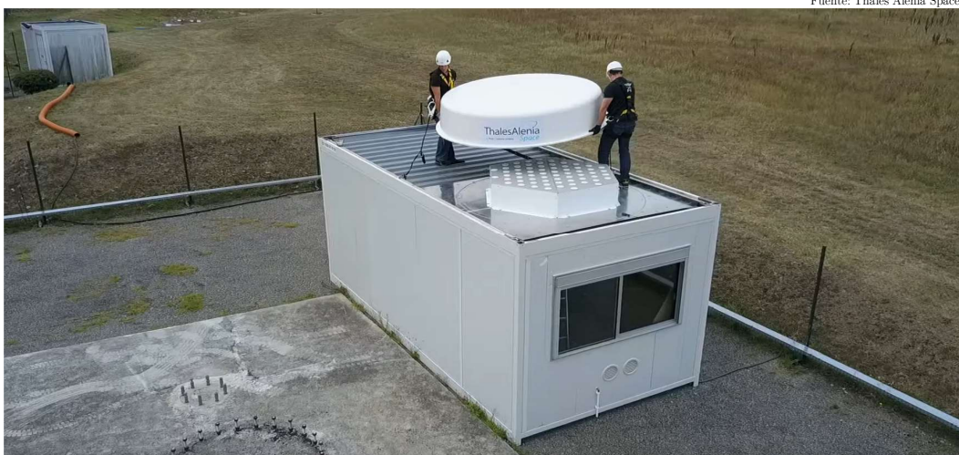
Figura 35: MEOLUT con array de antenas activas (MEOLUT La Reunión)
