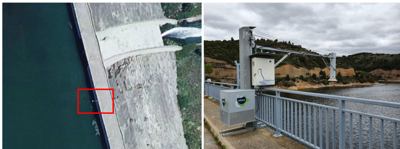
Figura 3.2: Udicación en planta de la sonda (izquierda) y foto del equipo en detalle (derecha).
