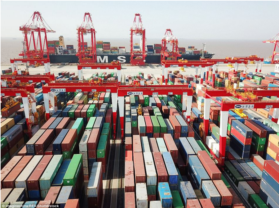
Figura 2. Vista aèria de la zona d'emmagatzematge d'una terminal de contenidors automàtica al port de Xangai (Xina).
