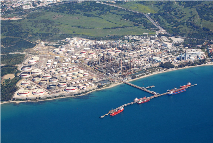
Figura 4. Vista aèria d'una terminal portuària de productes petrolífers i pantalà per a la càrrega i descàrrega de vaixells petrolers de CEPESA al port d'Algesires.
