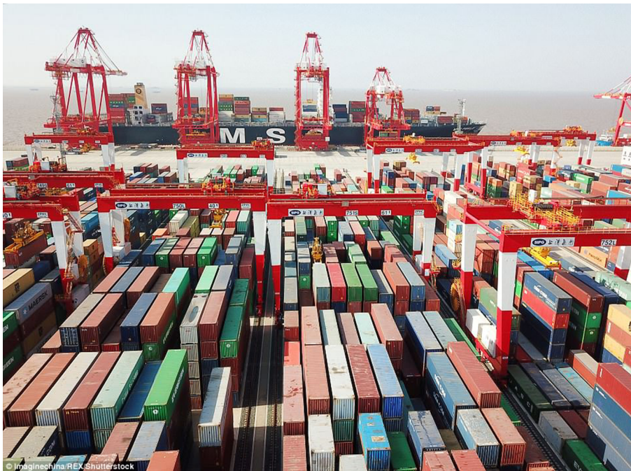
Figura 2. Vista aérea de la zona de almacenamiento de una terminal de contenedores automática en el puerto de Shanghai (China)
