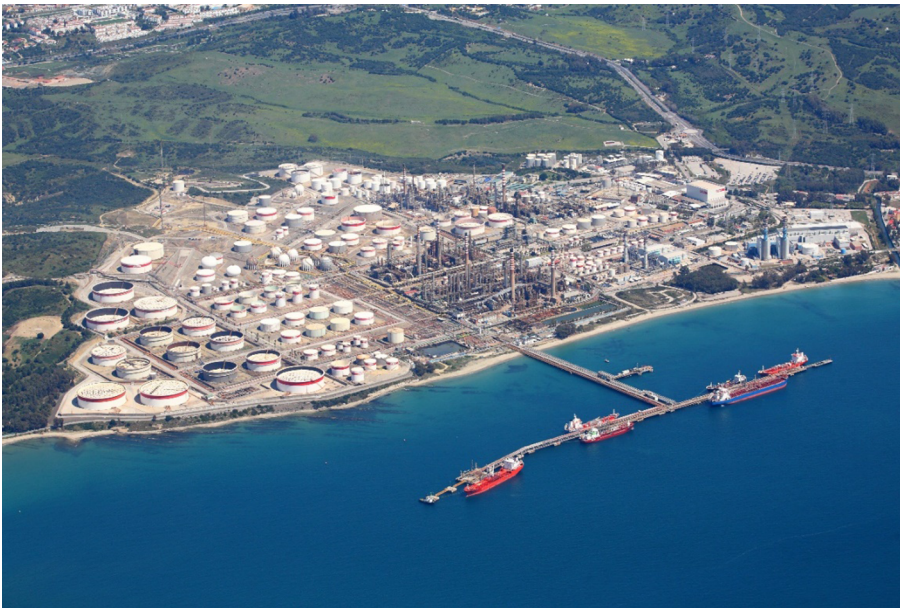
Figura 4. Vista aérea de una terminal portuaria de productos petrolíferos y pantalán para la carga/descarga de buques petroleros de CEPSA en el puerto de Algeciras
