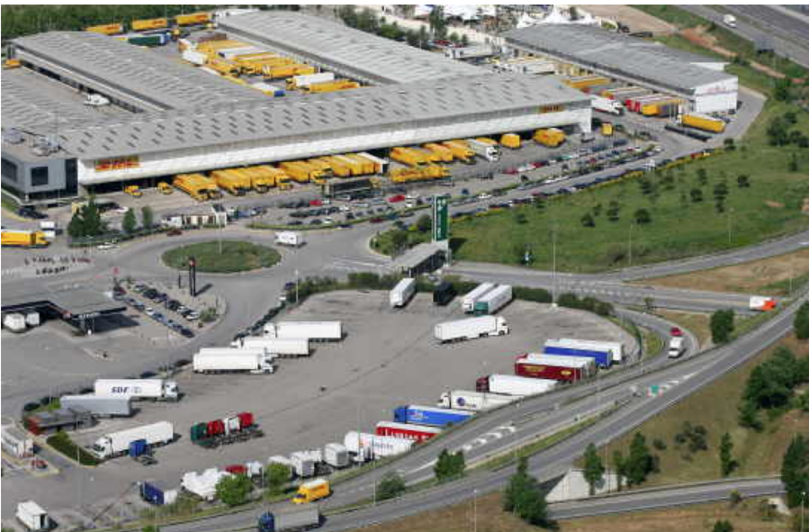
Figura 2. Plataforma logística de distribución del Área Metropolitana de Barcelona, enfocada a la actividad logística de alta rotación, cuyo promotor es CIMALSA (CIM Vallès)
