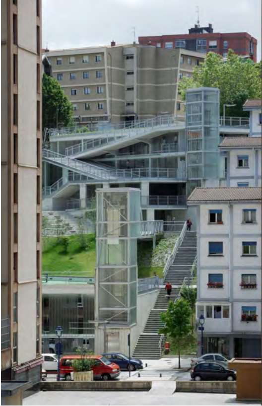
(48). Fotografía donde se aprecia la consecución de escaleras, rampas y ascensores que cosen los diferentes niveles del proyecto con su entorno.
