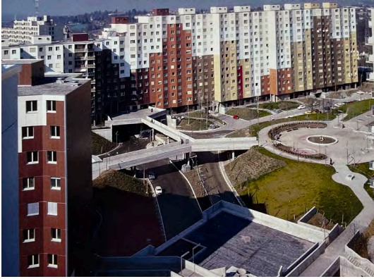
(15). Fotografía de las pasarelas peatonales elevadas en hormigón
