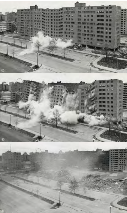
(04). Demolición del Pruitt-Igoe en 1972.
