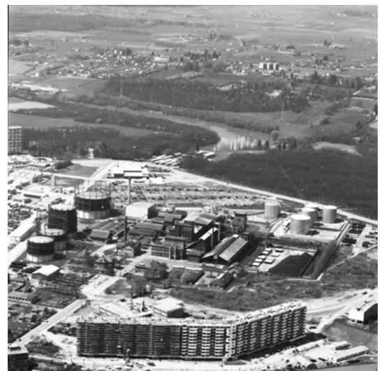
(35). Fotografía aérea con el edificio de Les Libellules en construcción en primer plano (1965)
