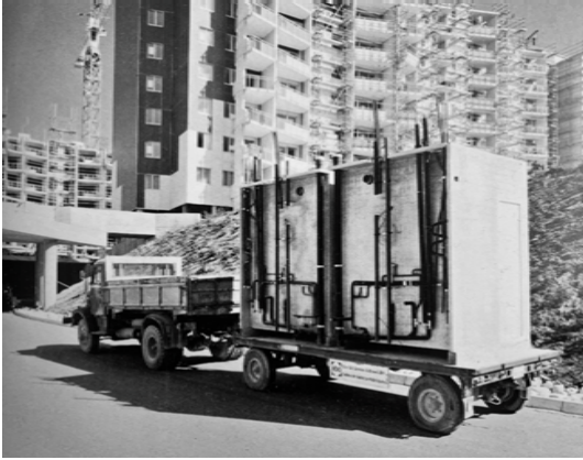
(22). Fotografía de la llegada de los paneles prefabricado a la obra
