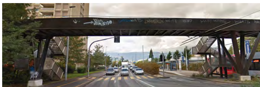
(14). Fotografía de la pasarela que conecta Avanchets con el parque de l'Etang. Se aprecia también la parada de tranvía Avanchets
