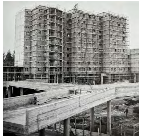
(21). Fotografías durante la construcción del conjunto donde se aprecia la construcción en hormigón in situ en la planta baja y prefabricado a partir del primer nivel
