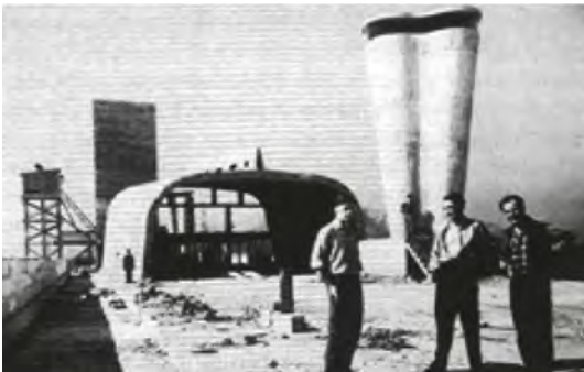
(15). Fotografía durante la construcción de la cubierta de la Unité d'Habitation en la que aparecen Woods, Boudiansky y Candilis (1952)
