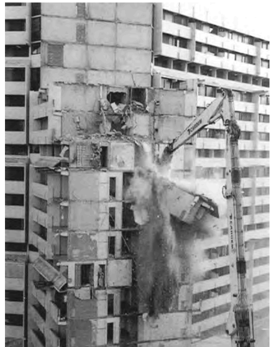
(09). Demolición de los edificios residenciales de Bellefontaine (Toulouse Le Mirail)
