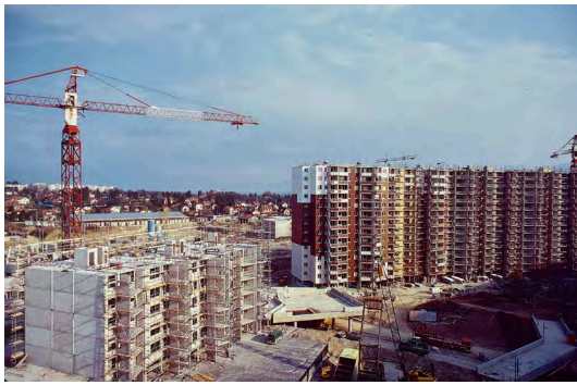
(22). Fotografía de la llegada de los paneles prefabricado a la obra
