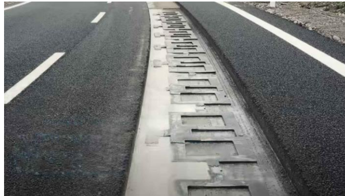
Figura 27: Instalación de bobinas en circuito Arena del Futuro [42].
