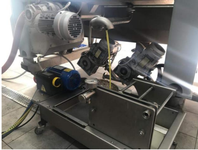
Figura 30: Filtre de plaques (Font: Fotografia pròpia, 2023)
